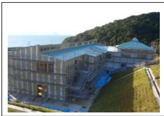
校舎の屋根（完成）と東側妻面
