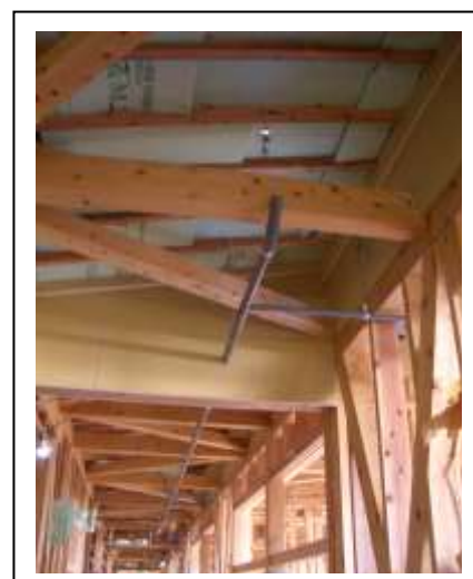
廊下の天井部分の配管工事の状況
