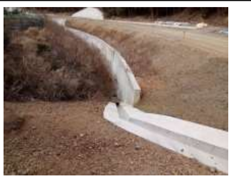
写真-10 過年度施工 (テールアルメ)
