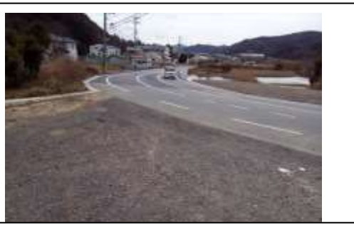
写真-4 下部側現道接続部
