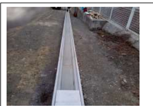
写真-5 U字側溝
