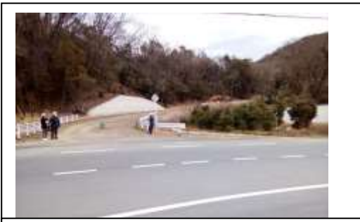
写真-3 下部側終点部新設交差点
