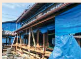
工事中の主屋
