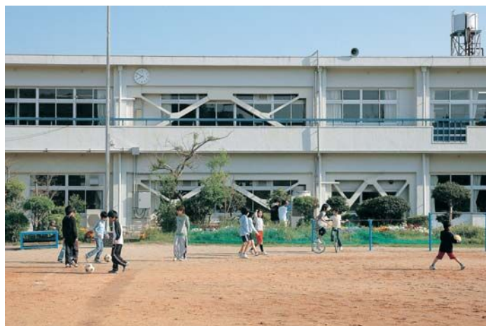
平成15年度に耐震化工事が行われた安楽島小学校の校舎。 鉄骨ブレース（筋交い）で補強しました。
