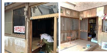
3-6「三郎治屋休憩所」 （交流施設）
