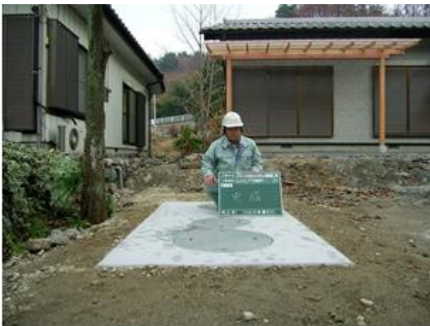
【写真10】工事完了写真
