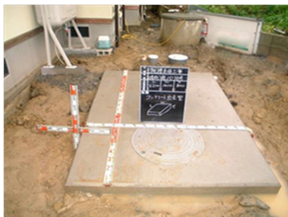
(上部スラブコンクリートの状況)
