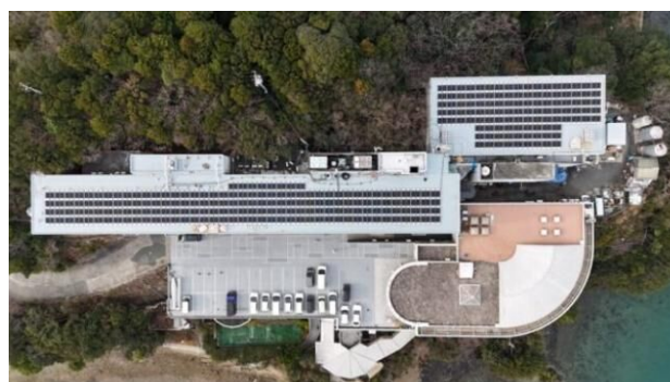
市内のホテルに設置された 屋根置き太陽光発電
