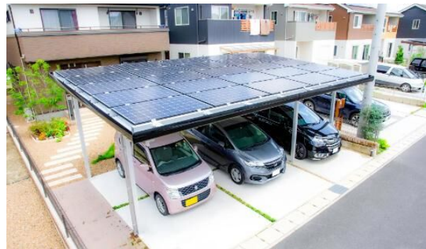
住宅、アパート用カーポート型太陽光発電
