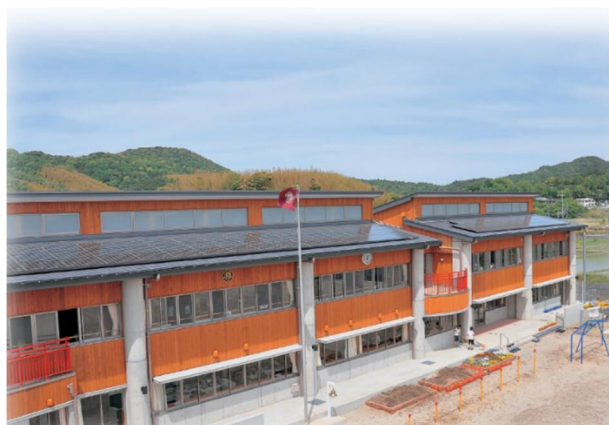
図 市内の中学校に設置された太陽光発電
