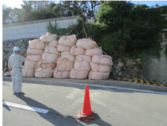
【国崎墓地用地の応急復旧の状況】
