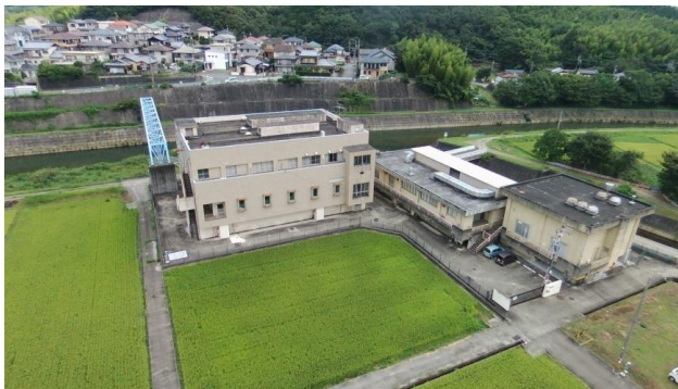
岩倉水源地の全景
