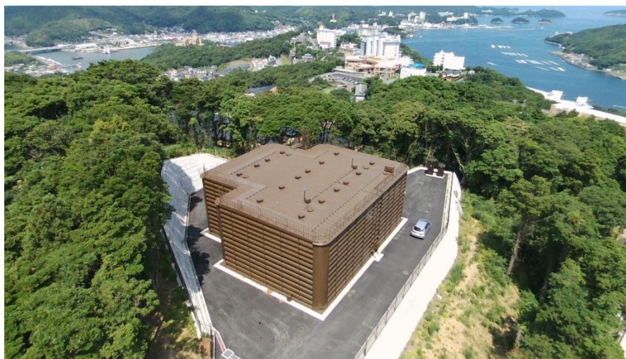
安楽島第1配水池
