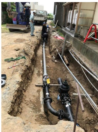
耐震管の布設
