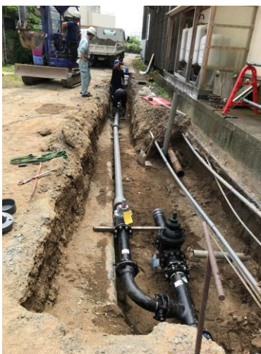
耐震管の布設
