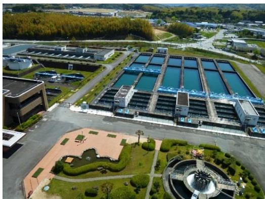
三重県企業庁 多気浄水場
