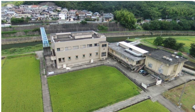
岩倉水源地の全景
