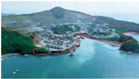
ドローンで撮影した菅島採石場の様子
