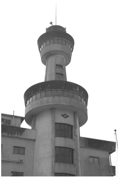
耐震化工事で取り壊す塔屋
