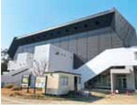
3月に改修工事が終了した鳥羽市民体育館（サブアリーナは引き続き増築工事を行っています。）
