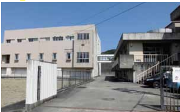
▲ 鳥羽の美味しい水を供給している岩倉水源地
