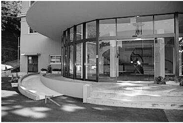
① 庁舎表玄関左にスロープができました。
