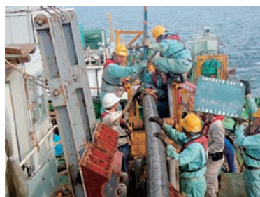
海底送水管布設作業
