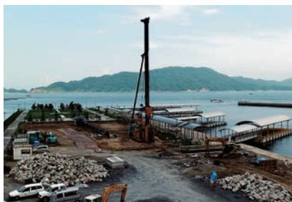
建設中のマリンターミナル
