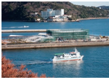
完成間近のマリンターミナル
