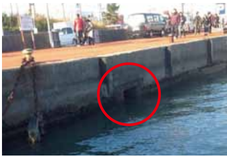
ミキモト真珠島横の排水路
