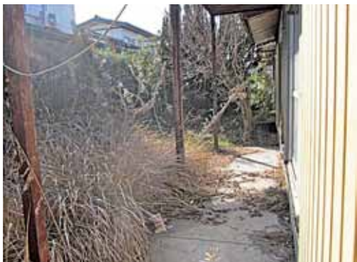
雑草につつまれた空き家
