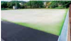
改修されたテニスコート
