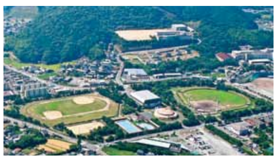
地方創生拠点整備交付金事業で整備を行う鳥羽市民体育館等
