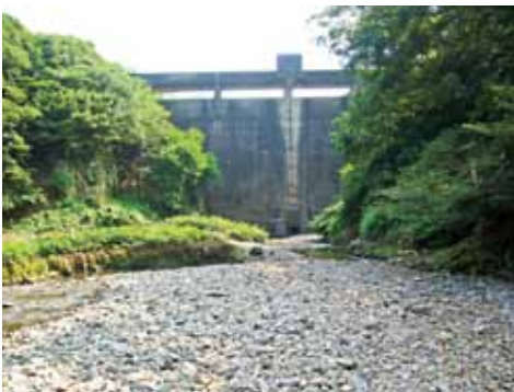
河内農地防災ダム
