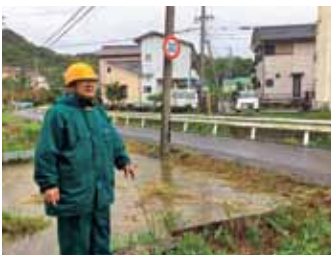
懸案になっている大明地区の浸水・冠水
