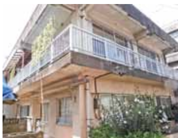
1階営島老人憩いの家、2階営島保育所
