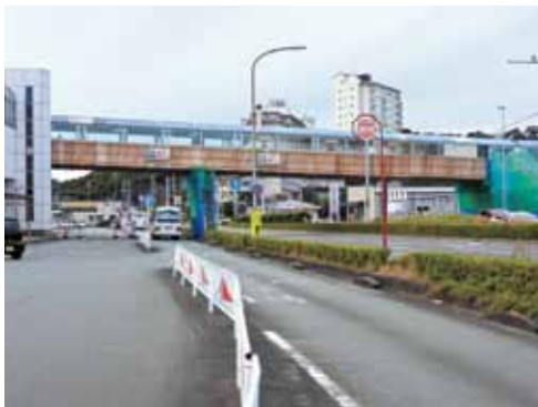
県が塗装工事を行っていた歩道橋
