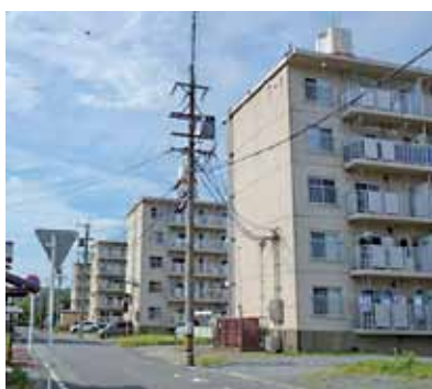
空き住戸が多くなった鳥羽市営住宅団地
