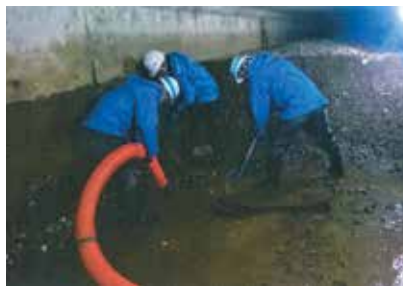
普通河川奥谷川災害復旧工事 (暗渠内浚渫工)現場作業写真
