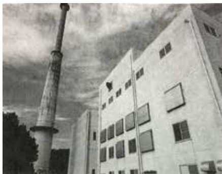
平成26年4月に稼働終了し解体撤去が必要な焼却処理施設
