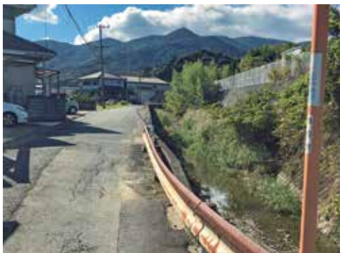
大雨の際には越水が危惧される紙漉川(市管理)の現況
