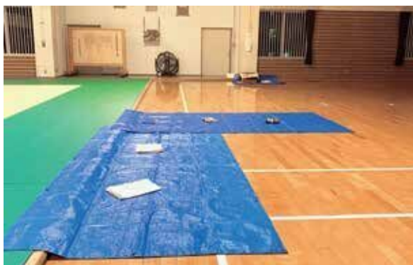
降雨時の雨漏り対策としてブルーシートが敷かれている 鳥羽市武道館の現状
