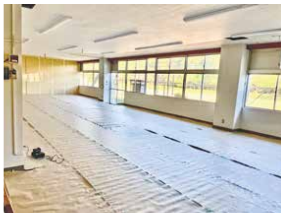
改修中の職員室
