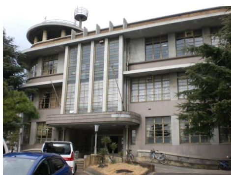
写真 1-9 神戸市立御影公会堂 昭和 23 年竣工（兵庫県）
