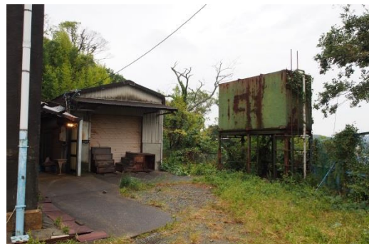
写真 3-3 旧校舎東側倉庫と受水槽
