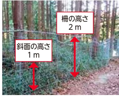
斜面や段差がある場所での防護柵の設置には注意が必要です。図のように柵の高さが2mあっても斜面の高さが1mあると、飛び越えられるリスクが高くなります。
