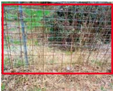
人目につかない場所は動物が柵を破壊するリスクが高くなるため、強固な資材にします。
