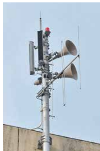
高性能スピーカーと赤色回転灯を設置した拡声子局
