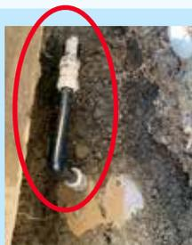
給水継ぎ手を交換して漏水を止めた
