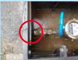
止水栓のパッキンが劣化しており、そこから漏水していたため止水栓ごと取り換えて漏水を止めた
