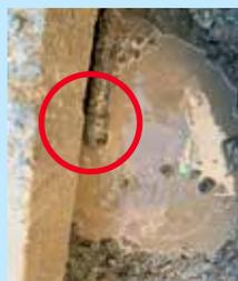
掘削すると給水管の接ぎ手に穴が開き漏水していた
