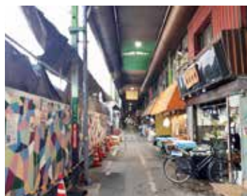
2回の火災で左側の 87店舗が焼けた旦過市場
