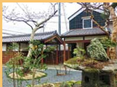
修理後の土蔵と新設した公衆トイレ
