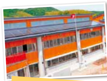
加茂小学校に設置した太陽光発電
