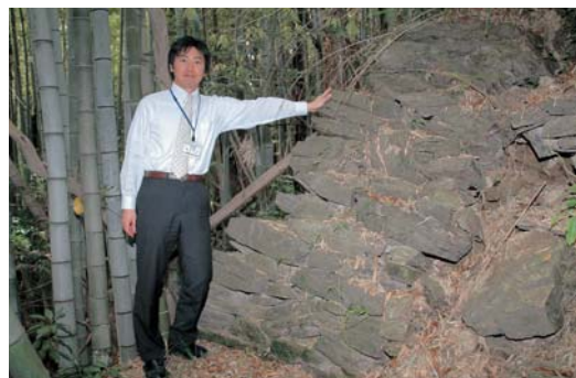
平たい石を積み上げた古い石積みです
