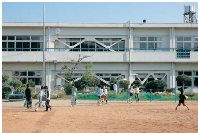
平成15年度に耐震工事が行われた安楽島小学校の校舎。 鉄骨ブレース（筋交い）で補強しました。
