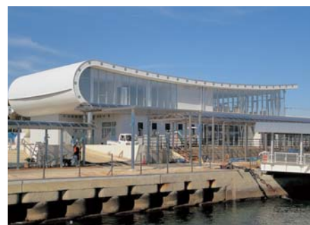
建設中の鳥羽マリンターミナル (荷捌き施設側)
