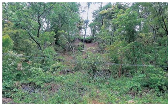
旧鳥羽小学校の海側斜面で発生した土砂崩れ現場
