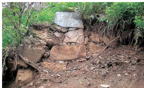
崩落跡から発見された石垣
