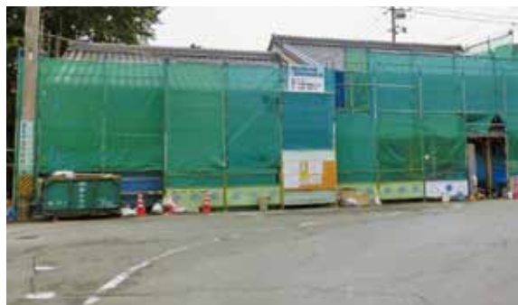
現在工事中の旧広野家住宅
