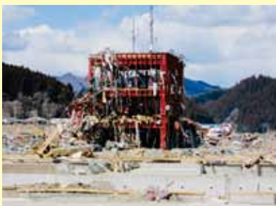
津波により被災した南三陸町防災庁舎
