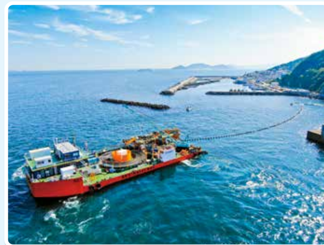
答志島神島間海底送水管布設工事
