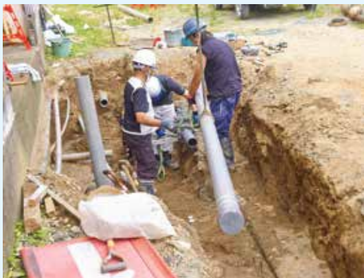
耐震管布設工事の様子
