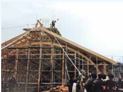
棟揚げ式の様子
